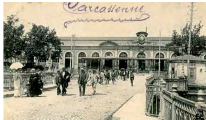
Le pont Marengo (détail de sols, garde-corps..) au dessus du canal et la relation à la façade de la gare (carte postale ancienne).
