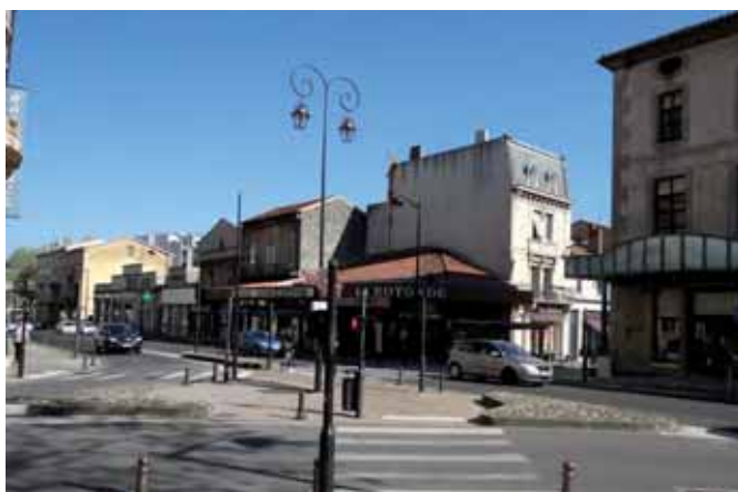
État actuel : le front bâti de faible qualité, possibilité de remplacement
