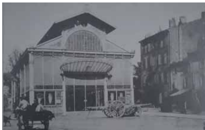
La halle derrière laquelle on devine des plantations. (carte postale ancienne). Sols simples.
