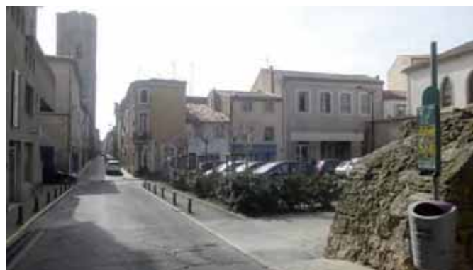
Etat actuel : l'arrachement du mur de la ville ( à valoriser), le seuil à marquer et la perspective vers l'imposant clocher de Saint-Vincent.
