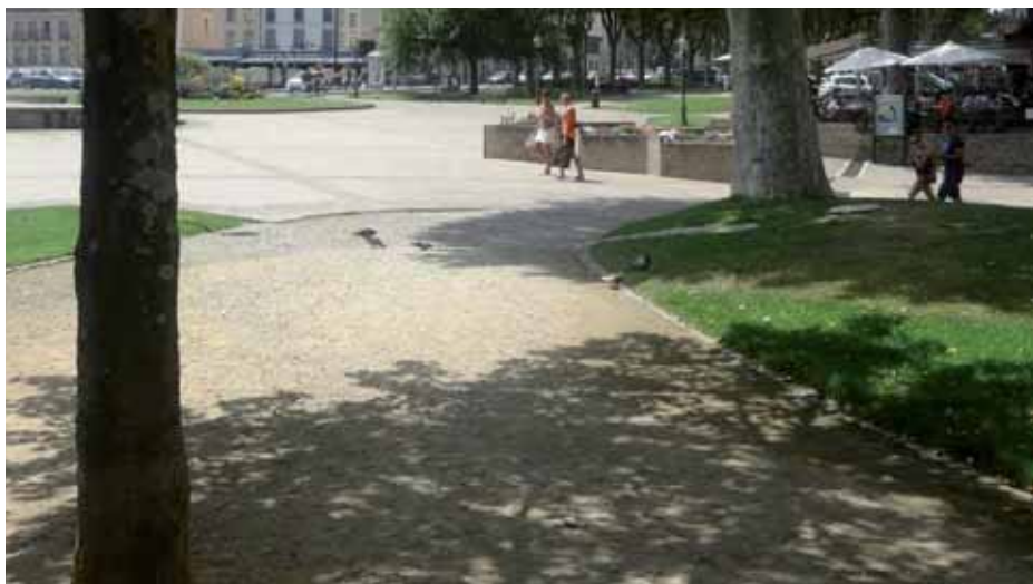
Boulevard Barbès Au premier plan, le traitement du tour de ville en stabilisé ocre clair qui rappelle la terre battue, le gravier...
